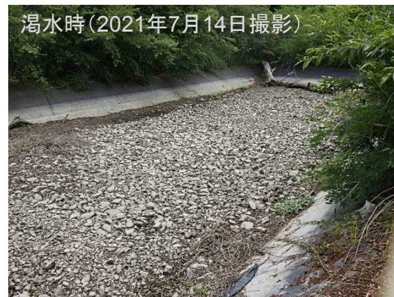
図4 沈砂池全景写真 (測定箇所x1近傍からx30方向を撮影)
