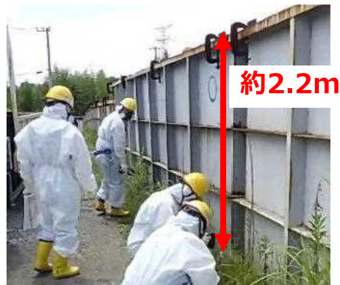
<ノッチタンクの設置状況>
