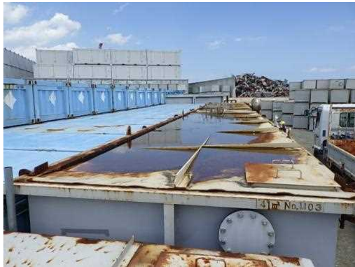
ノッチタンク上部の状況 (2021.7.6撮影)
