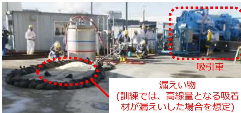
漏えい物回収訓練の様子
