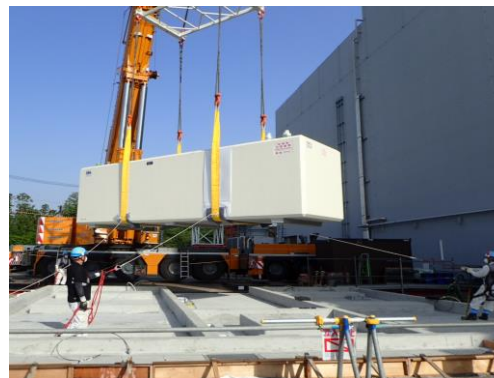
タンク設置作業の状況(2025年5月)
