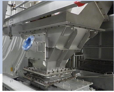
灰排出シュート改造後
