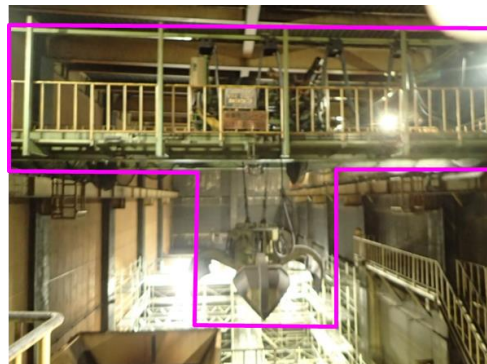
廃棄物クレーンの状況 (左：取替前，右：取替後)
