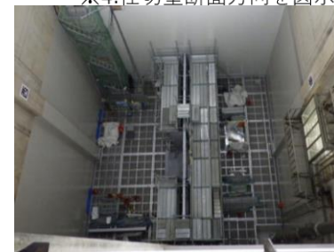
⑤ピット仕切壁設置
