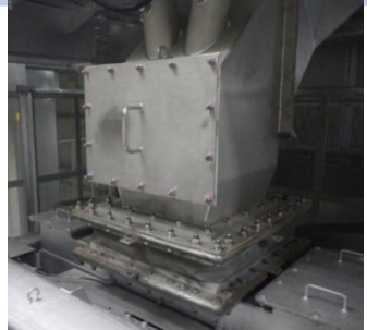
灰排出シュート改造前
