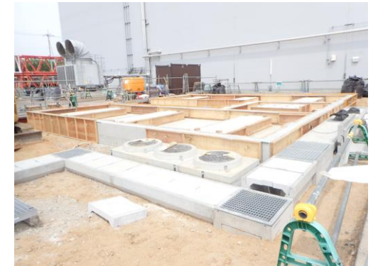
基礎設置作業の状況(2025年4月)
