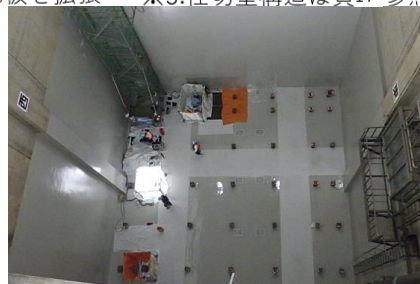
③ピットコンクリート補修後
