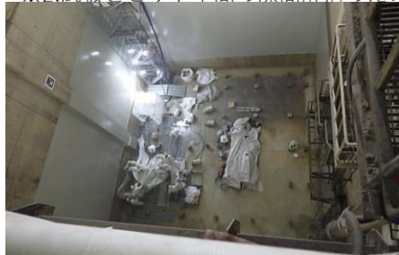
③ピットコンクリート補修中
