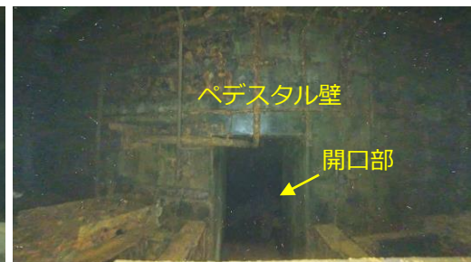
③：CRD交換用開口 外観
