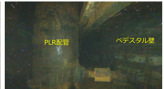
④：ペDESTAL外 東エリア
