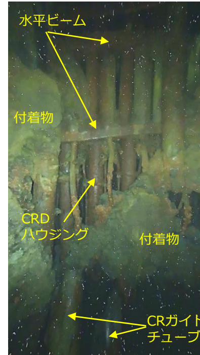
②：矢視の上部
