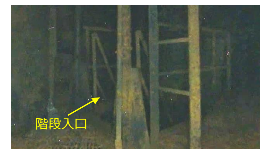
④：地下階段(南)
