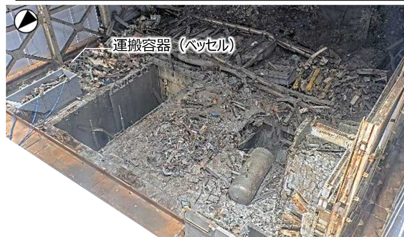
ガレキ撤去 開始後（撮影：2026年8月29日）
