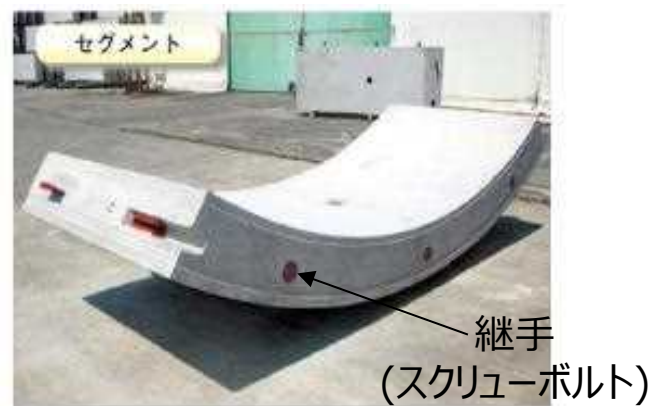
延長方向の継手(スクリーボルト)
