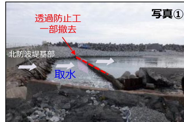
透過防止工撤去イメージ図
