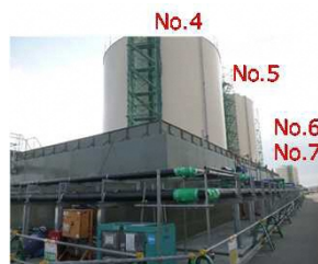
集水タンク増設
