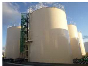
一時貯水タンク増設
