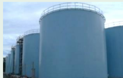
溶接型タンク
