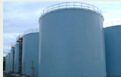
溶接型タンク
