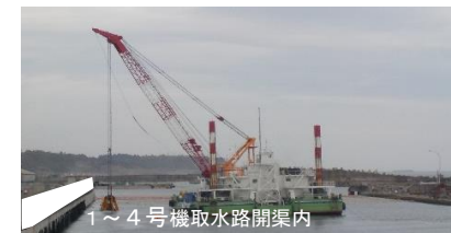
海側遮水壁防衝盛土工事の様子
