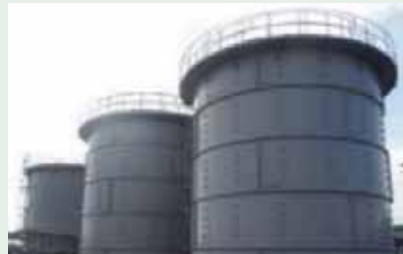
フランジ型タンク
