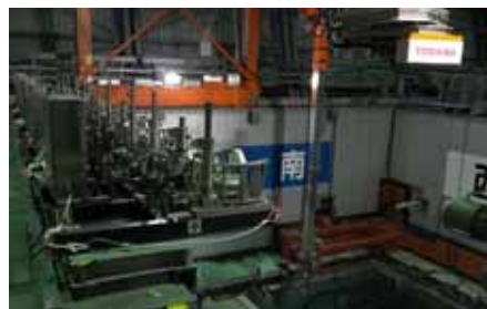
オペレーティングフロアの様子
