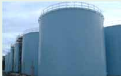
溶接型タンク
