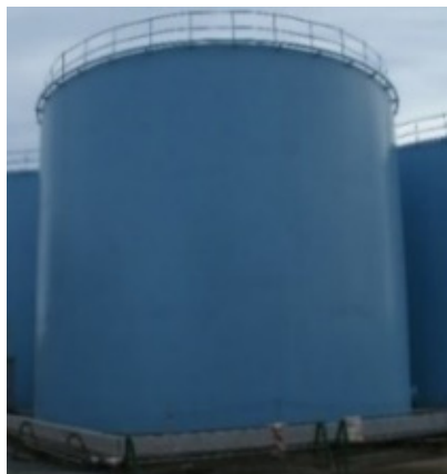
溶接型タンク
