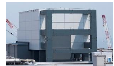
原子炉建屋外観
