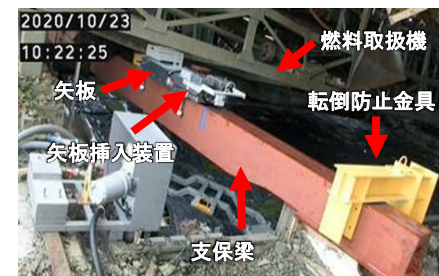
③燃料取扱機支保設置作業完了後の状況
