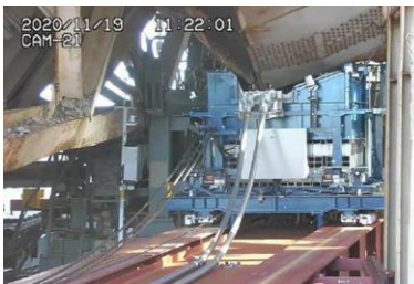
支保台車設定完了
