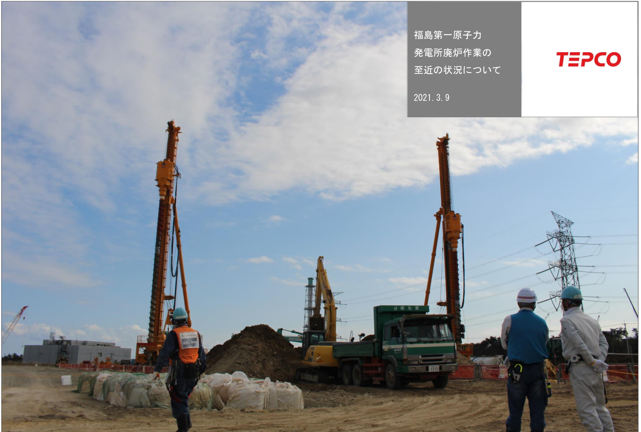
廃棄物関連施設の地盤掘削の様子
