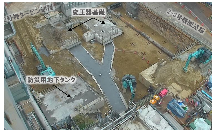
燃料取り出し用構台設置準備作業 (2号機原子炉建屋南側ヤード状況)
