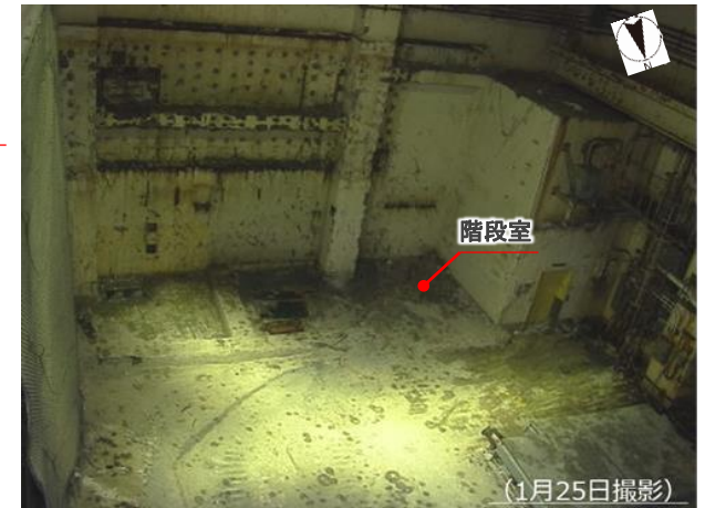
解体後の現場状況写真(2023年1月25日撮影)
