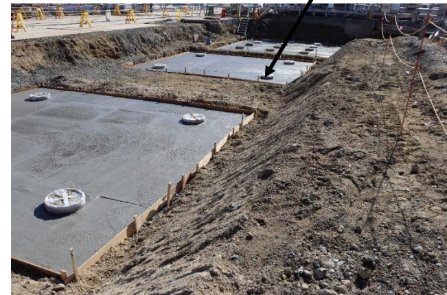
海水移送配管基礎の構築状況
