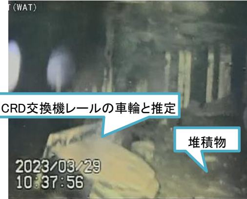
CRD交換機レールの車輪と思われる構造物
