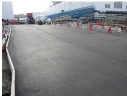
3号機原子炉建屋山側エリア (2023年4月20日)
