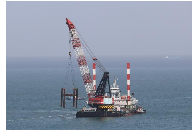
測量櫓（下段）撤去状況
