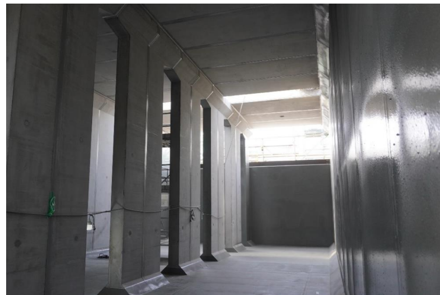
内部の状況（防水塗装完了）
