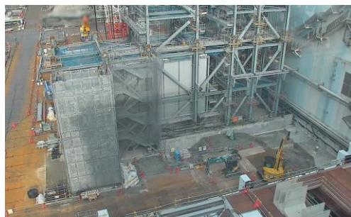
2号機原子炉建屋南側エリア (2023年4月18日)
