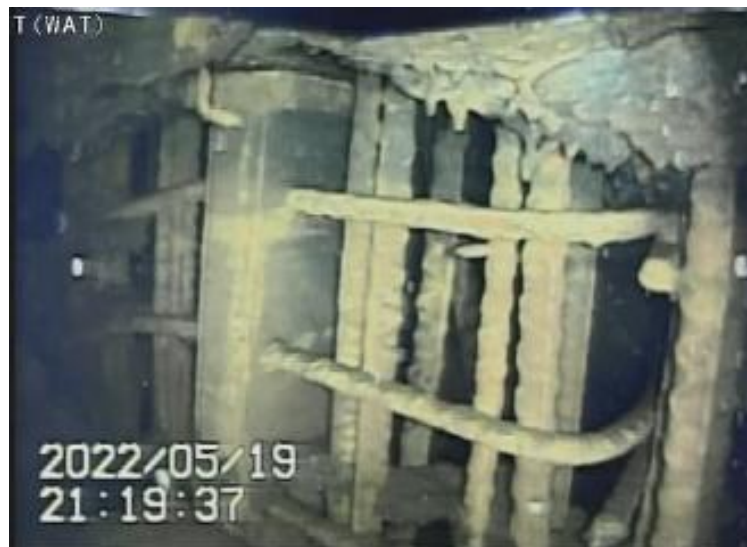
アクセス開口部付近 調査状況
