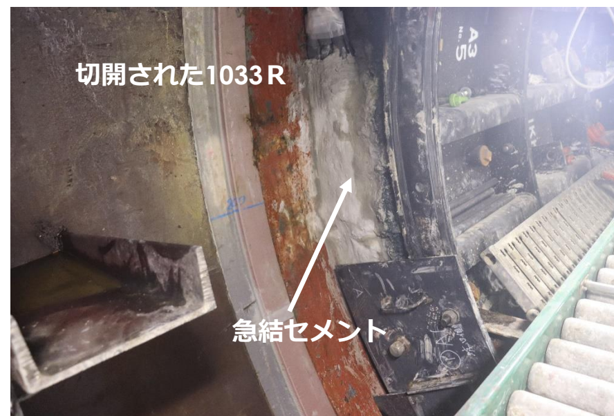
トンネル先端状況（止水工事の状況）
