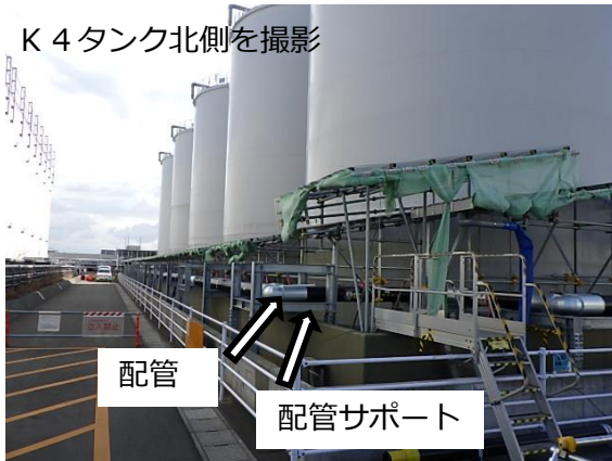
循環配管・サポート設置の状況
