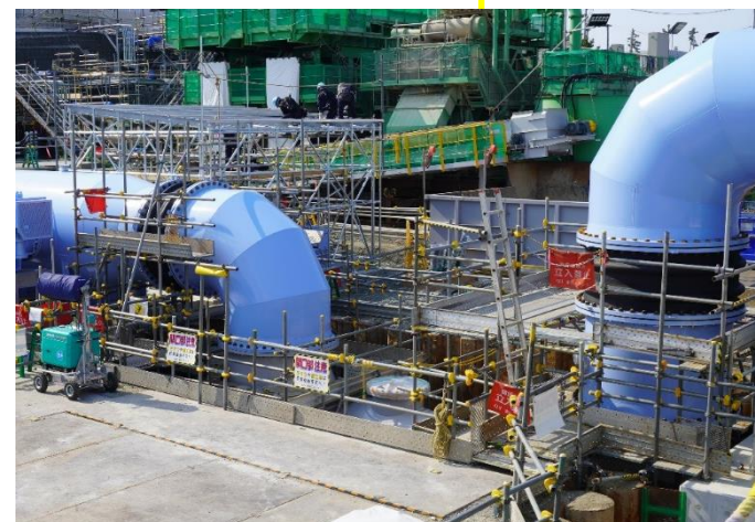
海水移送配管・海水配管ヘッド設置の状況
