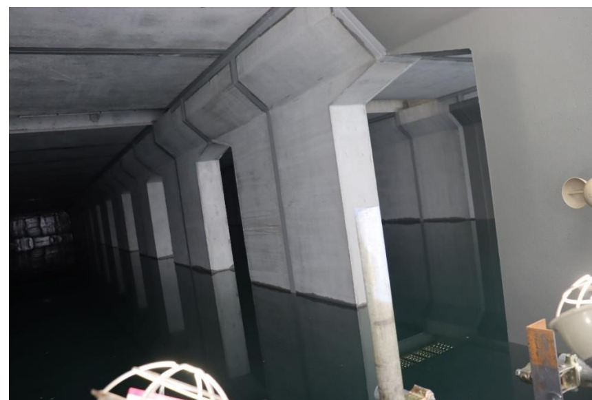
内部の状況（注水完了）
