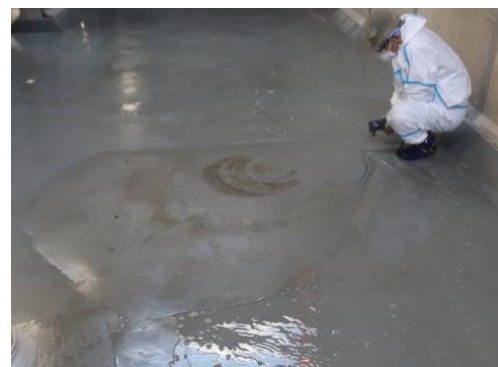
膨れ箇所を切断し、防水塗装下部の雨水を排水
