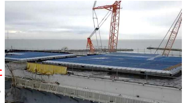
3号機タービン建屋 損傷部補修
