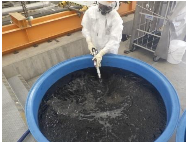
吸着材交換作業
