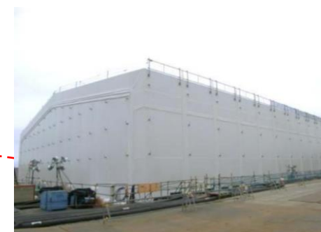
多核種除去設備（ALPS）
