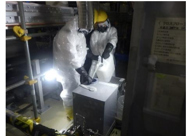
クロスフローフィルター洗浄作業
