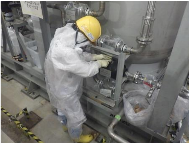
吸着材逆洗作業
