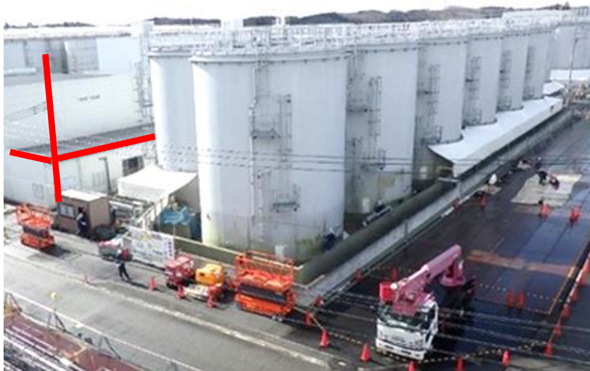
タンク解体前のJ9エリアタンク（2025.2.13）
