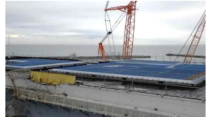
3号機タービン建屋 損傷部補修
