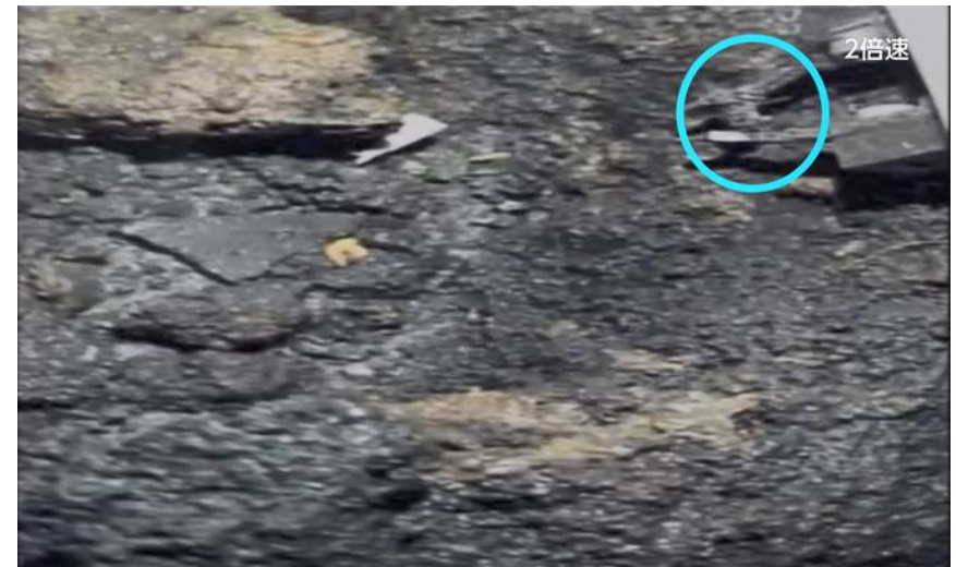
2024.10 撮影 2号機:先端治具で燃料デブリを把持した様子
