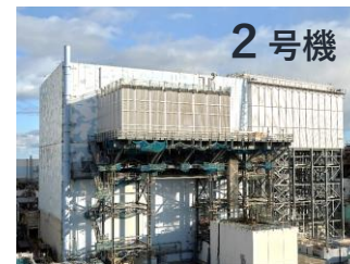
2号機 燃料取り出し開始 2026年6月
