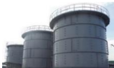
フランジ型タンク
