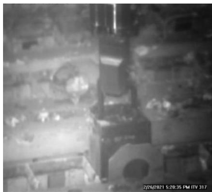
3号機での燃料の吊り上げ (566体目)
