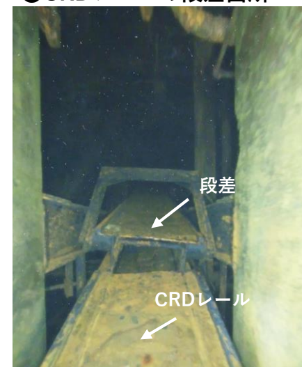
④CRDレールの段差箇所
