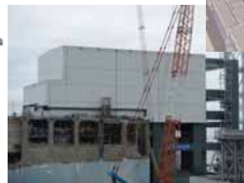
屋根・外壁設置(南西面)
