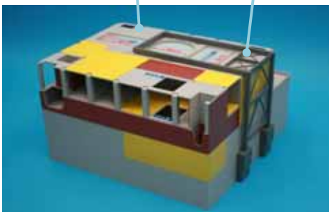
燃料取扱機支持用架構設置(南西面)
