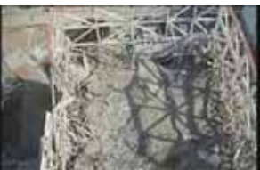
1号機(カバー設置前)
