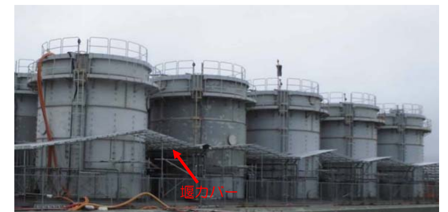
<タンク堰カバー設置 現場状況>
