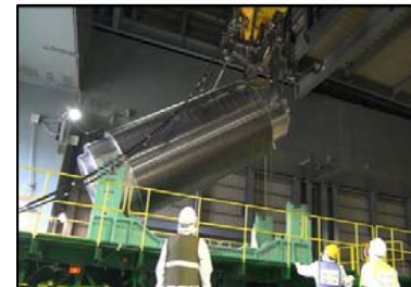
トレーラーへの積み込み (撮影日：平成25年11月21日)
