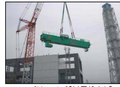
クレーン部材吊り上げ (撮影日：平成25年6月7日)
