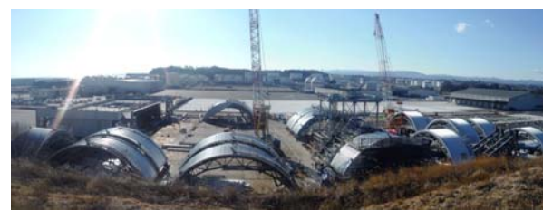
建屋カバーの製作状況(小名浜)
