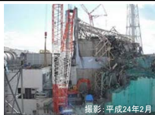
撮影：平成24年2月 ガレキ撤去前
