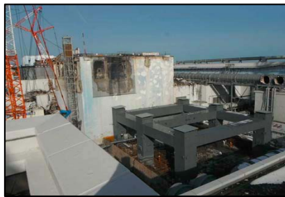
第一節 鉄骨建方完了 (撮影日：平成25年1月14日)
