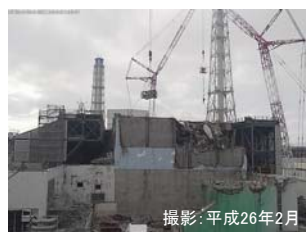
撮影：平成26年2月 ガレキ撤去後
