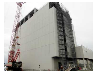
6月完成予定の大型休憩所の建設工事状況
