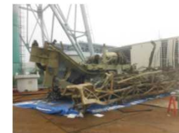
撤去した燃料交換機
