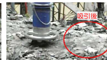
小ガレキ吸引状況（吸引後）
