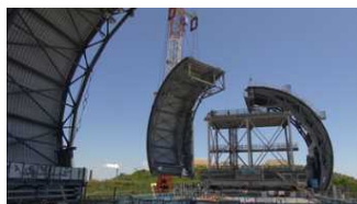
小名浜ヤードにおける燃料取り出し用カバー組立訓練 (撮影日：2016年6月3日)
