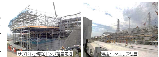
<9-7. 海拔4m及び7.5mエリアの未舗装箇所への屋根掛けの状況>
