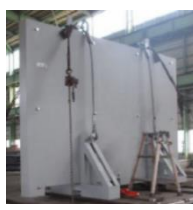
③150mmの鉄板を用い衝立形状の遮へいを設置
