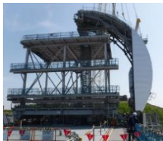
ドーム屋根組立訓練
