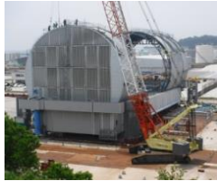
ドーム屋根組立訓練
