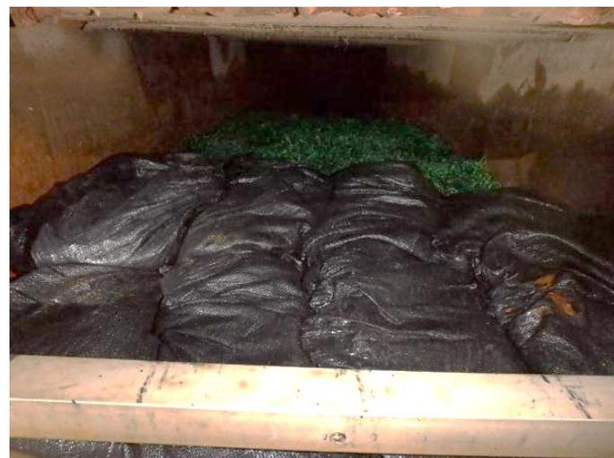
写真3 34(2) 内部の浄化材 (交換後)
