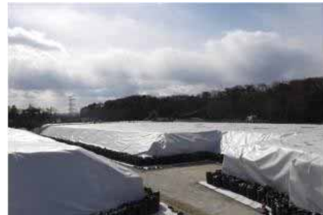
写真3 養生エリア③ 作業完了
