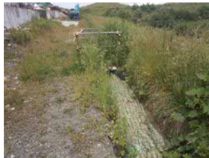
写真5-1 土側溝（作業前）
