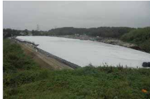
写真2 養生エリア①② 作業完了
