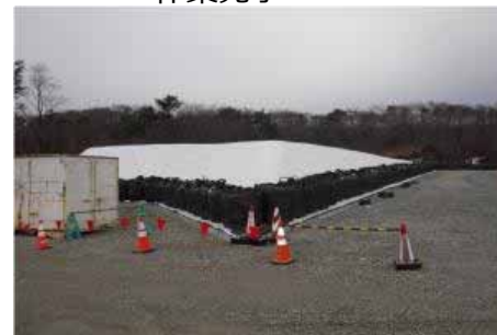
写真4 養生エリア④ 作業完了
