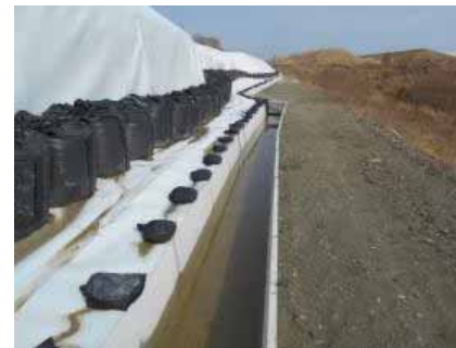
写真5-2 側溝（作業完了）
