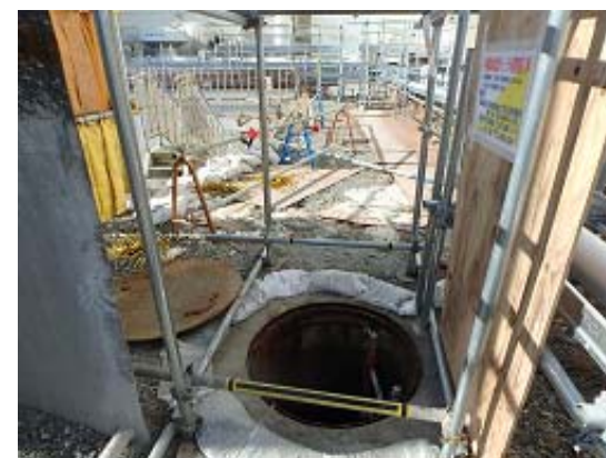
開口部Ⅱ MH開口状況
