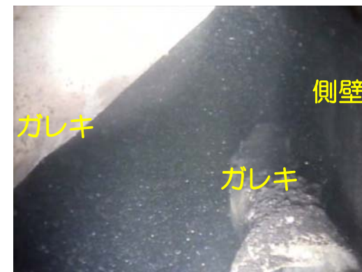
カメラ調査状況
