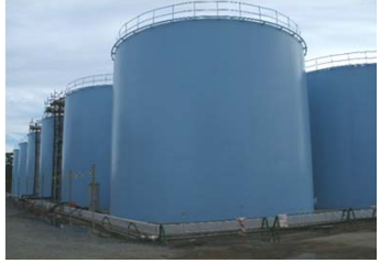
貯蔵タンク ( Sr処理水 1 )
