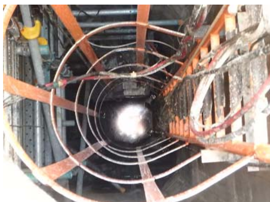
MH内部の状況
