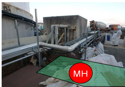
開口部Ⅱ 地上部状況 (着手前)
