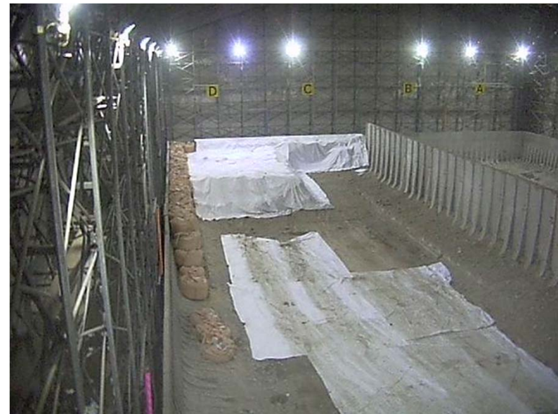
③コンテナ移動 完了状況 (H27.2.24)
