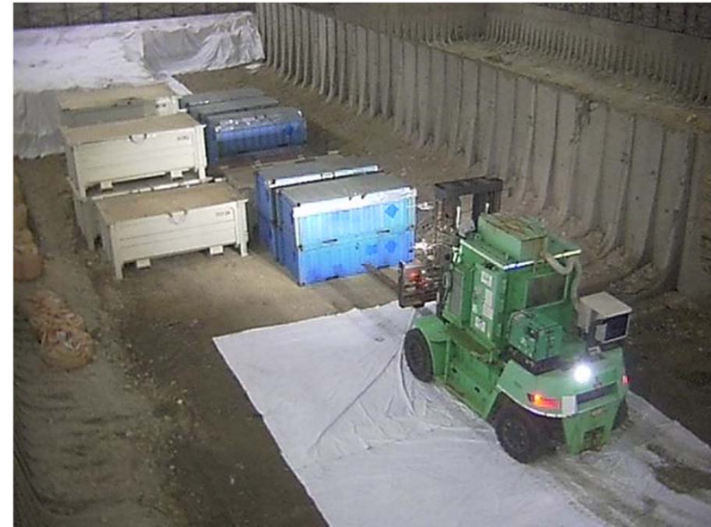
②コンテナ移動 作業状況 (H27.2.23)
