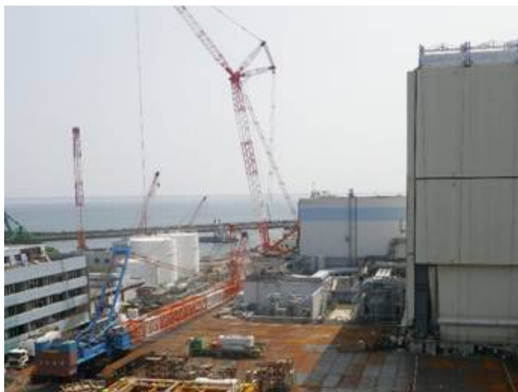
750tクローラクレーン
