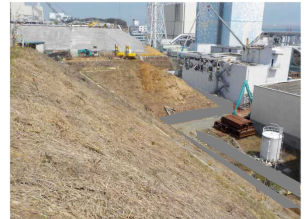
現場状況写真（写真②）
