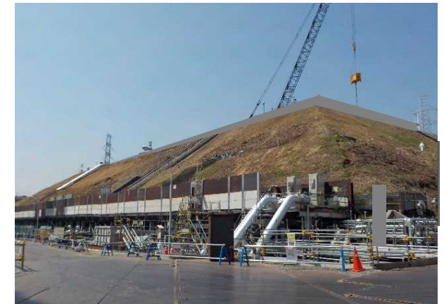
現場状況写真（写真②）
