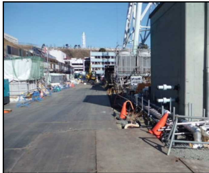
現場状況写真
