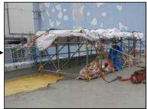
【写真⑧】仮設テント盛替状況（4月1日）
