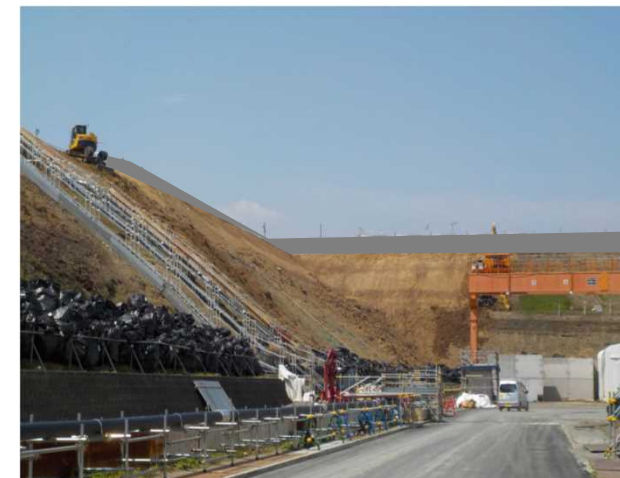
現場状況写真（写真②）
