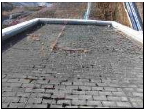
【写真①】作業前
