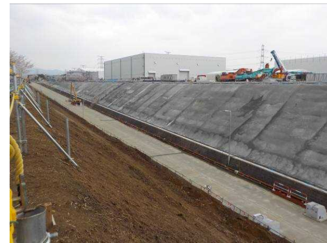
現場状況写真（写真②）
