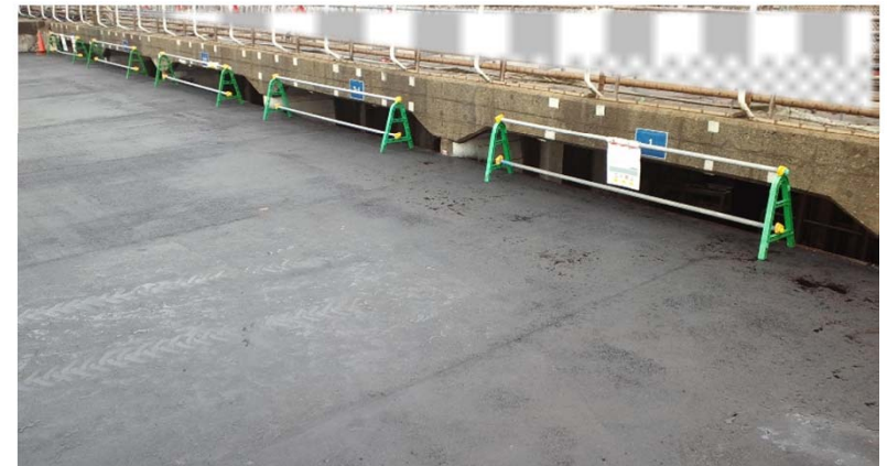
4/7日 舗装2層目完了(残1層)
