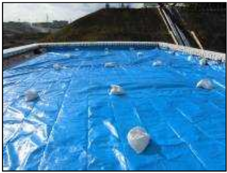
【写真②】ブルーシート設置（3月2日）
