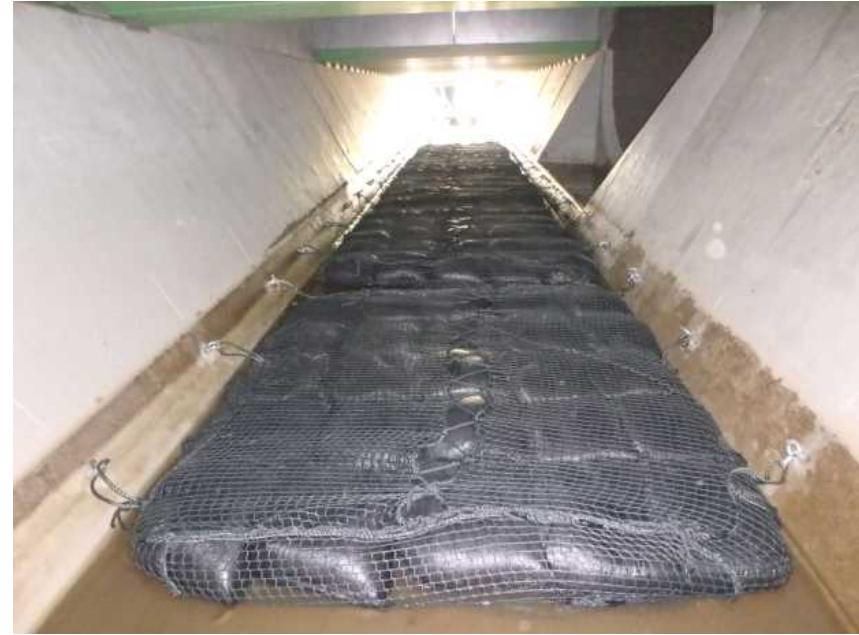
B C排水路暗渠部【写真②】
