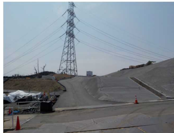
現場状況写真（写真①）
