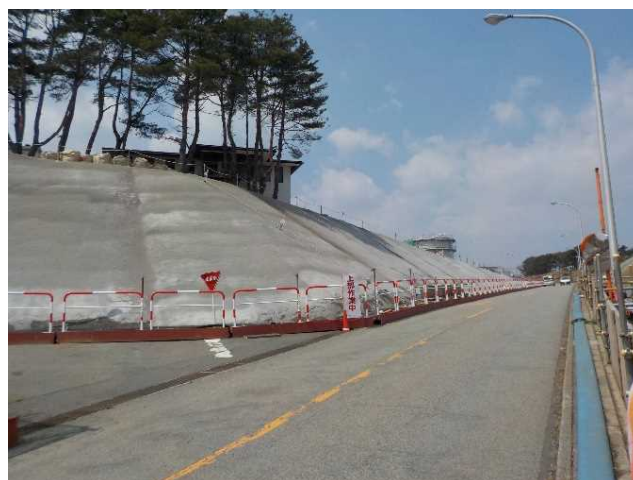
現場状況写真（写真①）
