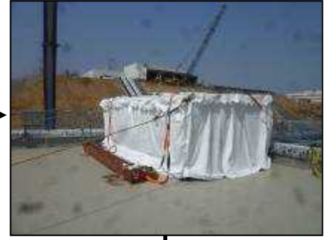
【写真④】仮設テント設置完了（3月31日）
