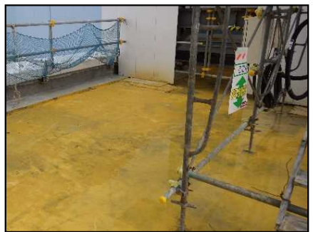
【写真③】ルーフブロック・敷砂撤去後 ストリップابلペイント塗布完了 (4月18日)
