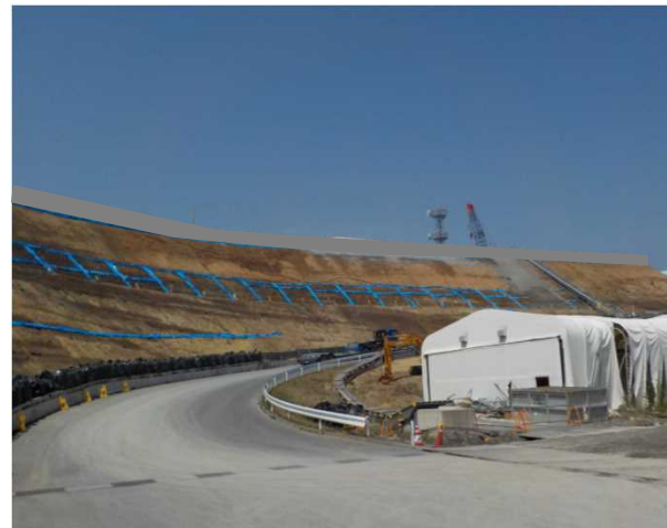
現場状況写真（写真①）
