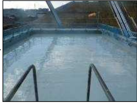
【写真③】ウレタン防水完了（3月14日）
