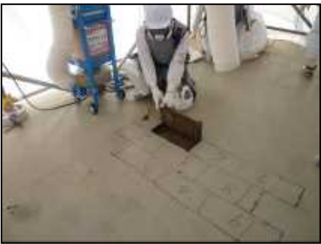
【写真⑤】汚染源撤去開始（3月30日）
