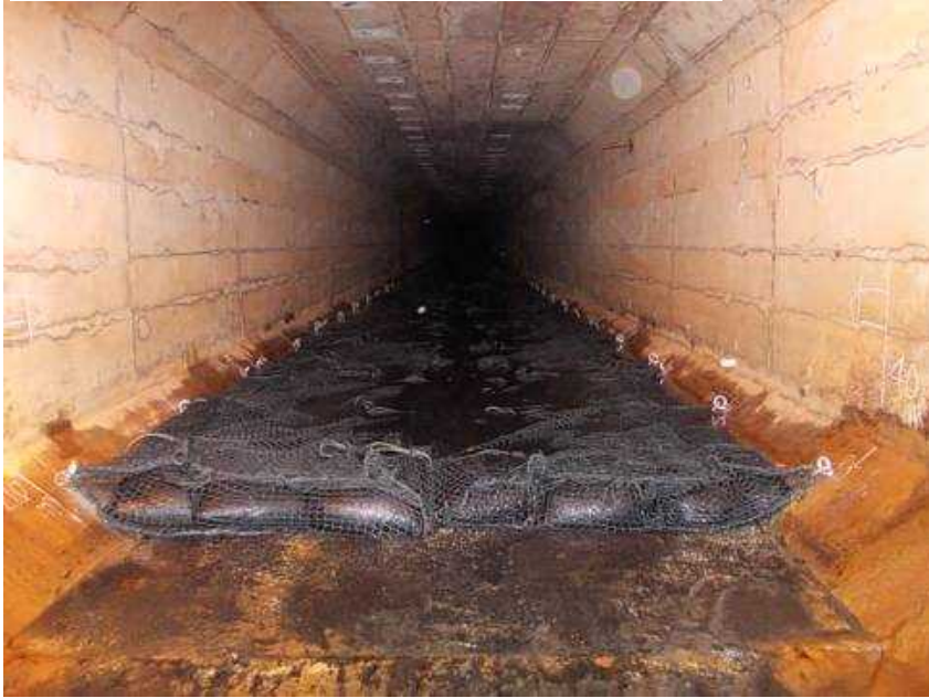
A排水路暗渠部【写真①】
