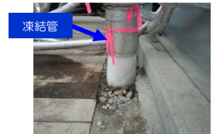
(陸側遮水壁 試験凍結箇所例)
