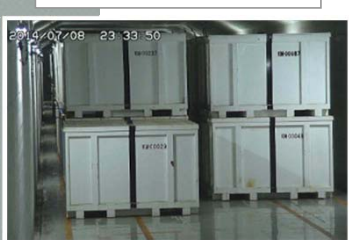
固体廃棄物貯蔵庫
