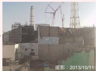
大型ガレキ撤去後
