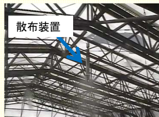
<飛散防止材の散布状況>
