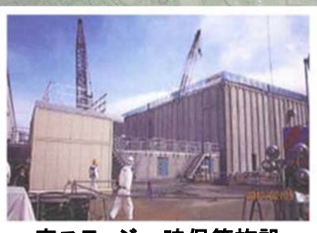
廃スラッジ一時保管施設
