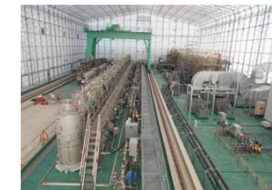
(高性能多核種除去設備)
