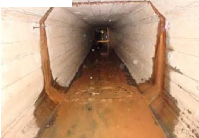
清掃前（A系：5号西側暗渠）
