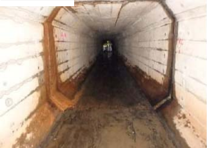
清掃後（A系：5号西側暗渠）
