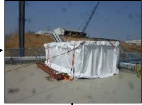
【写真④】仮設テント設置完了（3月31日）
