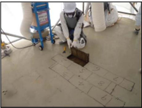
【写真⑤】汚染源撤去開始（3月30日）
