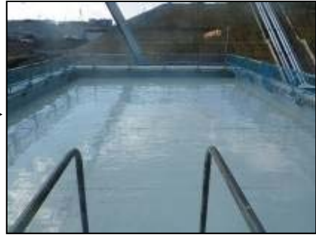
【写真③】ウレタン防水完了（3月14日）
