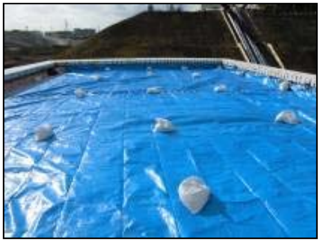
【写真②】ブルーシート設置（3月2日）
