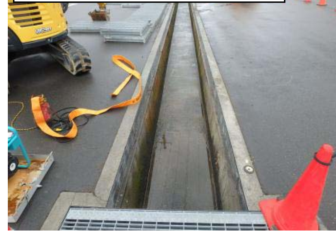
清掃後（C系：新事務棟駐車場）
