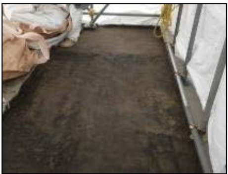
【写真⑥】仮設テント内ルーフブロック・敷砂撤去状況（3月31日）
