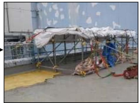
【写真⑧】仮設テント盛替状況（4月1日）
