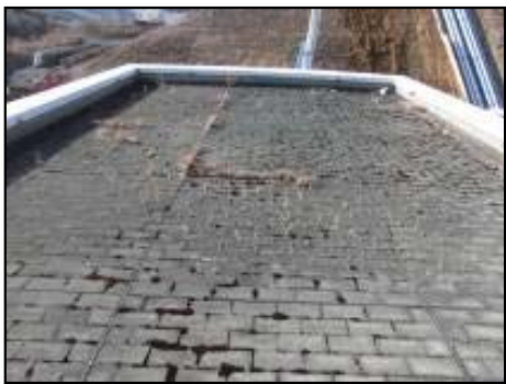
【写真①】作業前
