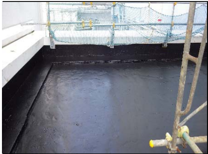
【写真④】仕上げ防水中 (4月25日)
