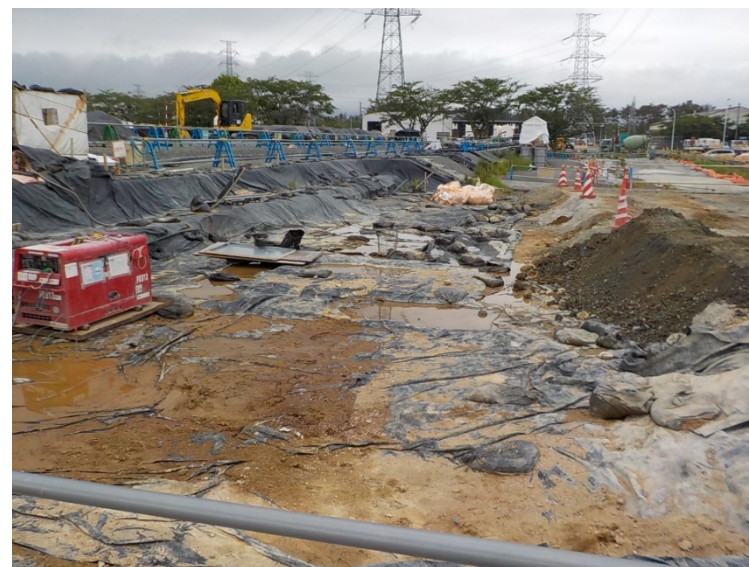
掘削終了時の状況
