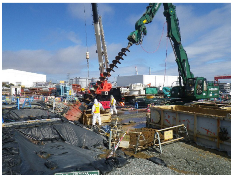
掘削時の状況
