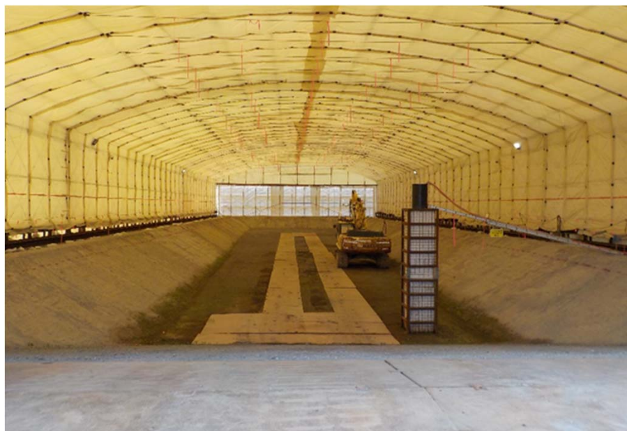
覆土式一時保管施設第3槽全景
