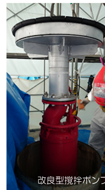
薬剤を投入した後、ポンプを上下させて鋼管壁に地下水を噴射することで洗浄する
