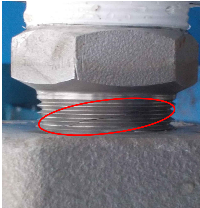
継手(ニップル)ネジ部の割れ
