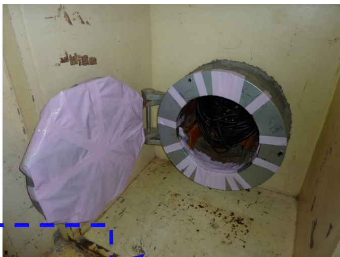
2号機X6ペネ定検時の状況写真
