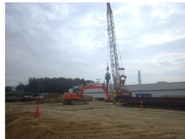
作業状況写真
