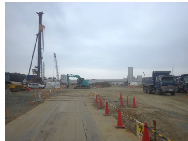
現場の全景写真
