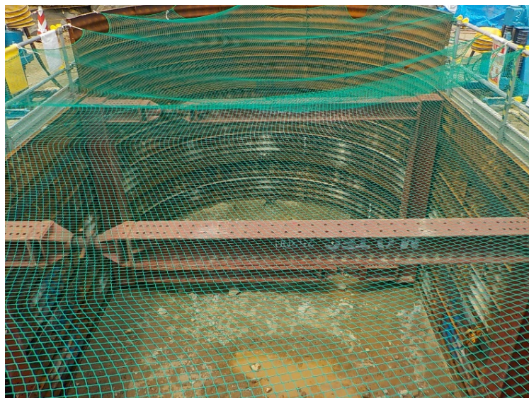
写真② 接続柵部 立坑構築
