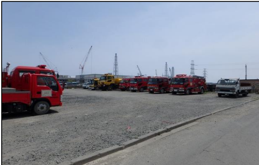
【写真②(35m盤)】北側エリア:舗装施工前
