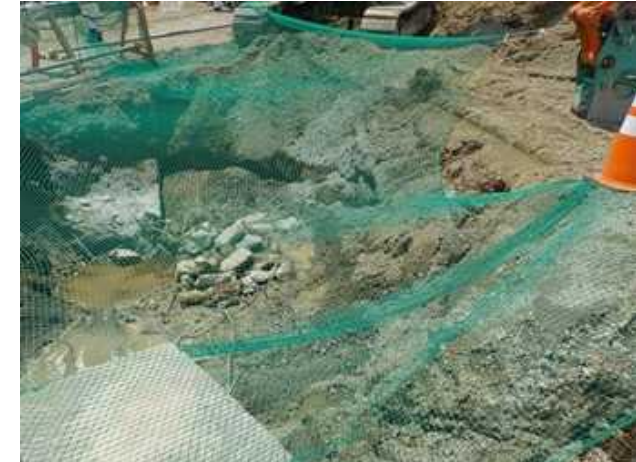
写真① 接続部 埋設物撤去
