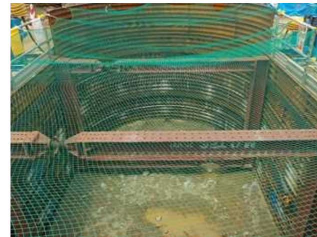
写真② 接続部 立坑構築
