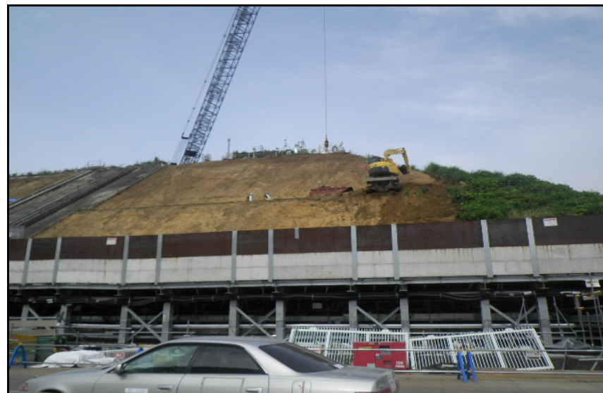
【写真③(35m盤)】1～4号法面:表土剥ぎ取り施工状況
