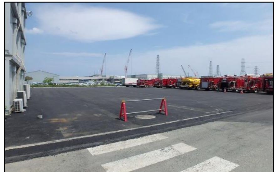
【写真②(35m盤)】北側エリア:舗装施工後
