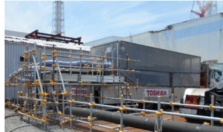
モバイル式処理装置
