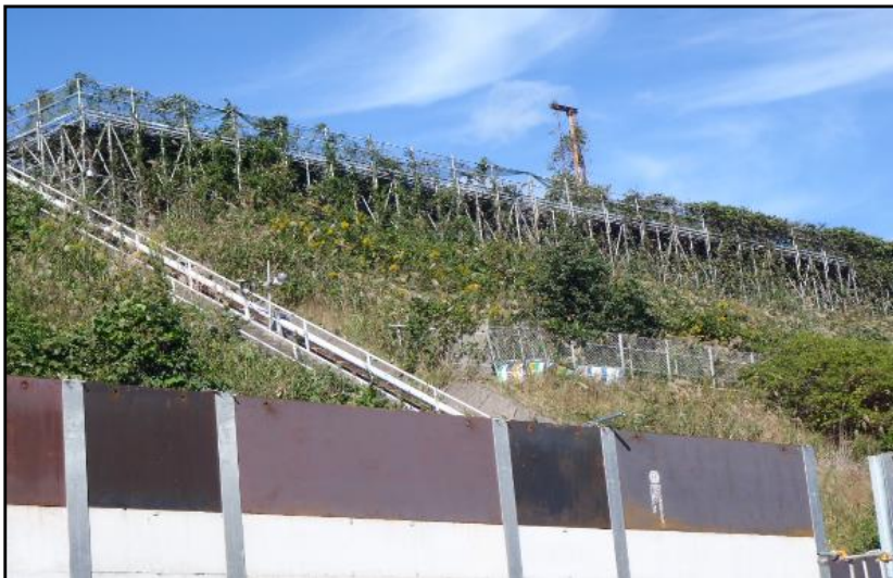
【写真④(35m盤)】1～4号法面:モルタル吹付け施工前
