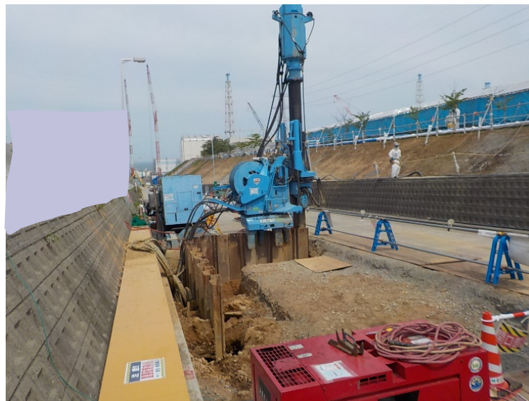
写真③ 西側工リア接続柵部 土止矢板打設
