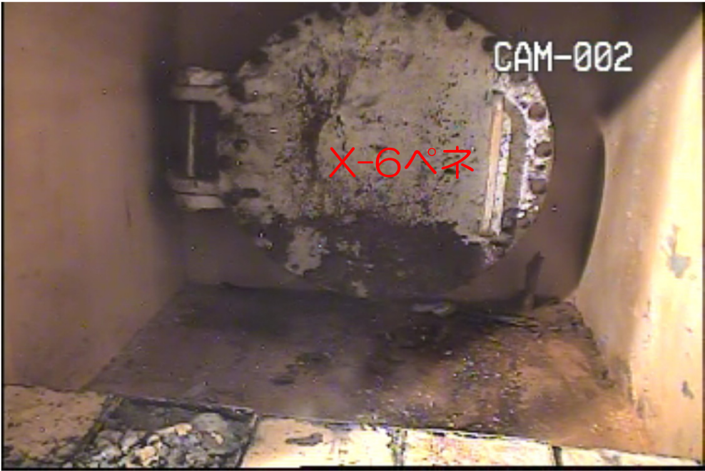
背面鉄板撤去後
