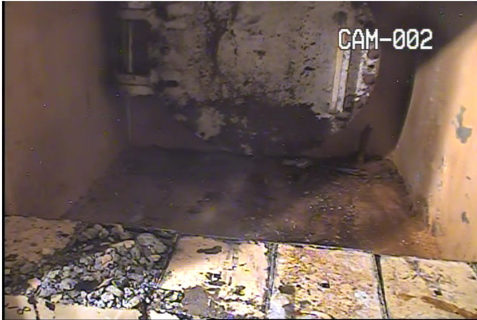
ブロック撤去前の状況
