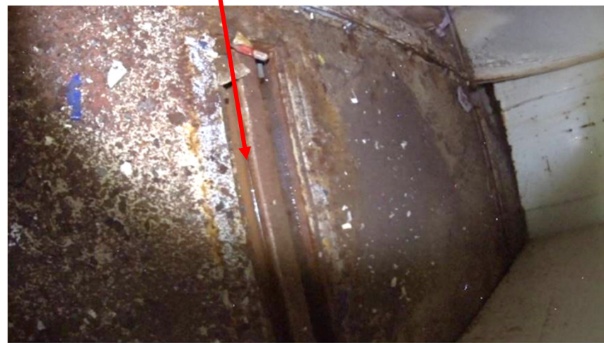
レール溝に水溜りあり
