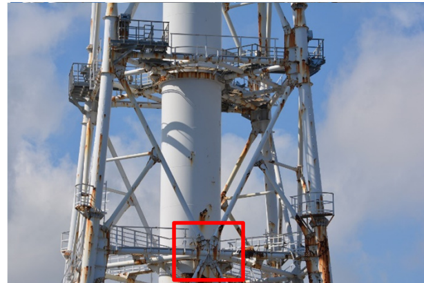
点検写真(b部)
