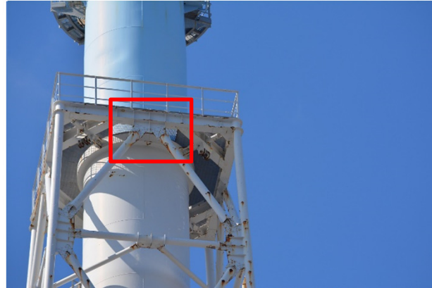
点検写真(a部)
