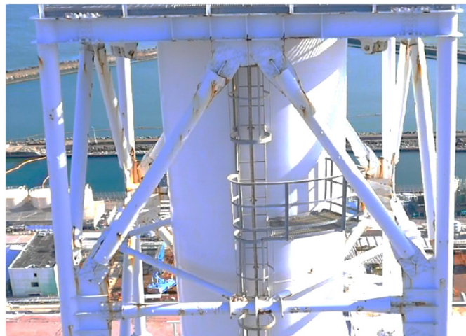
④西側(GL111m付近)
