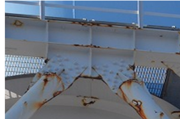
点検写真(a部拡大)
