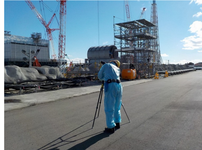
望遠カメラによる撮影状況
