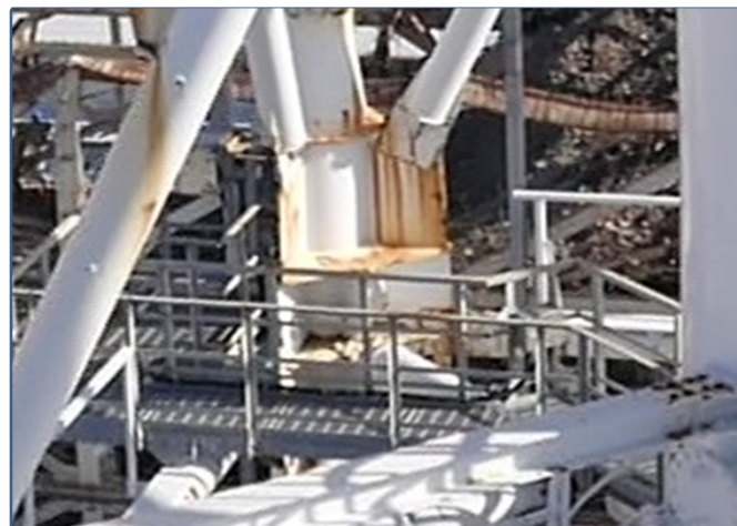
②北東側(GL55m付近)
