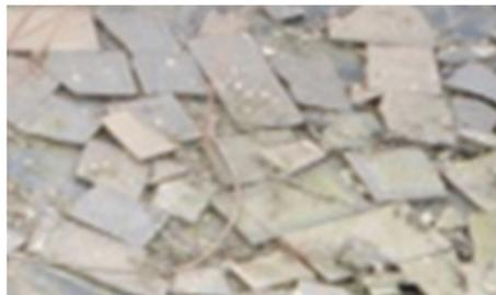
ルーフブロックは、崩落屋根スラブ表面から剥がれ折り重なるような状態であるため、その隙間に飛散防止剤は廻りこんでいる
