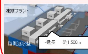
建屋への地下水流入を抑制するため、建屋を囲む陸側遮水壁の設置を計画。2016年3月より海側及び山側の一部、2016年6月より山側の95%の範囲の凍結を開始。残りの箇所についても段階的に凍結を進め、2017年8月に全ての箇所の凍結を開始。2018年3月、陸側遮水壁はほぼ全ての範囲で地中温度が0℃を下回ると共に、山側では4～5mの内外水位差が形成され、深部の一部除去完成し、サブドレン・フェーシング等との重層的な汚染水対策により地下水位を安定的に制御し、建屋に地下水を近づけない水位管理システムが構築されたと判断。また、3月7日に開催された汚染水処理対策委員会にて、陸側遮水壁の地下水遮水効果が明確に認められ、汚染水の発生を大幅に抑制することが可能となったとの評価が得られた。
