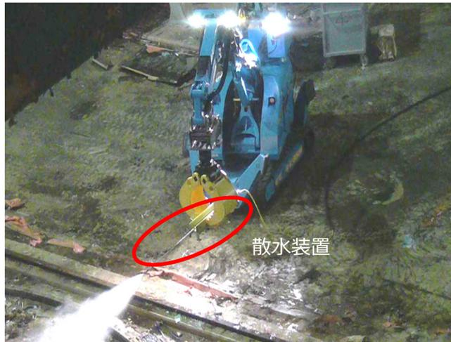
①散水状況（ダスト抑制対策）
